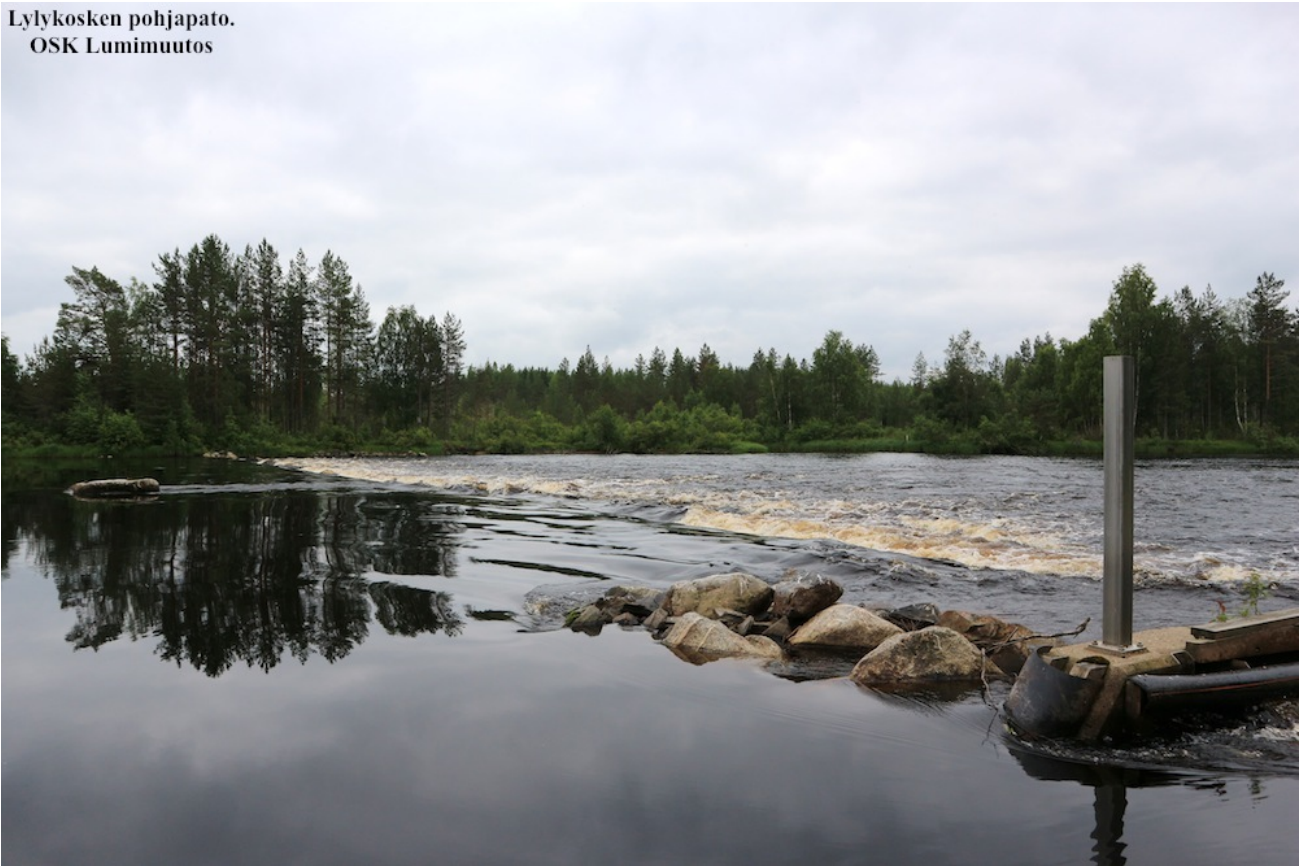
Lylykosken pohjapato. Kuva: OSK Lumimuutos, 2017
