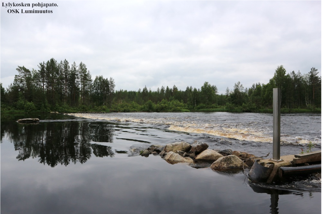
Lylykosken pohjapato. Kuva: OSK Lumimuutos, 2017
