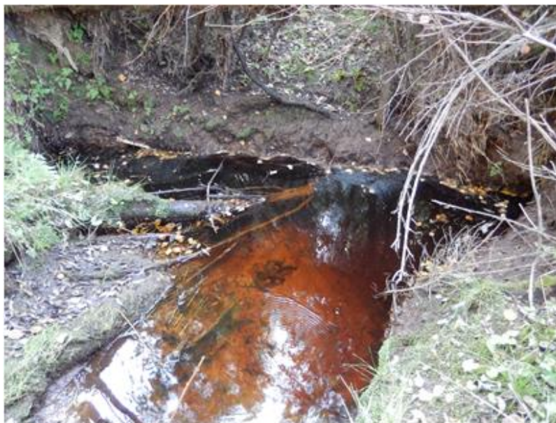
KUVA 5. Painunut ojarumpu uomassa (Kuva: Teija Mäkelä 2014)
