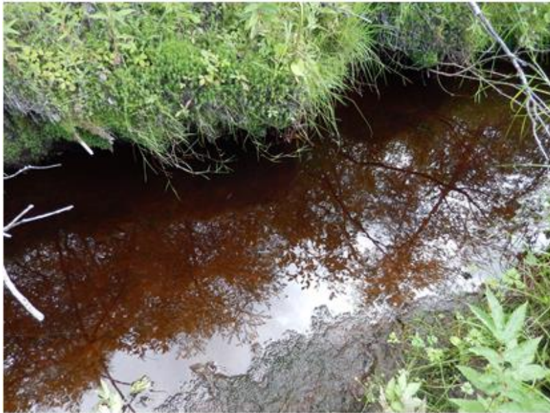
KUVA 14. Valtaojaan kerääntynyttä kiintoainesta (Kuva: Teija Mäkelä 2014)
