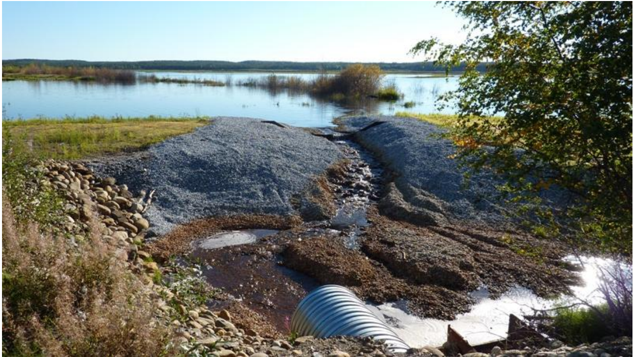
Kuva 5. Linnunsuon kosteikko ja kosteikon purkuojan suu. Kalkkikivisepelillä pyritään nostamaan veden pH-arvoa. Kuva: Tomi Nokelainen
