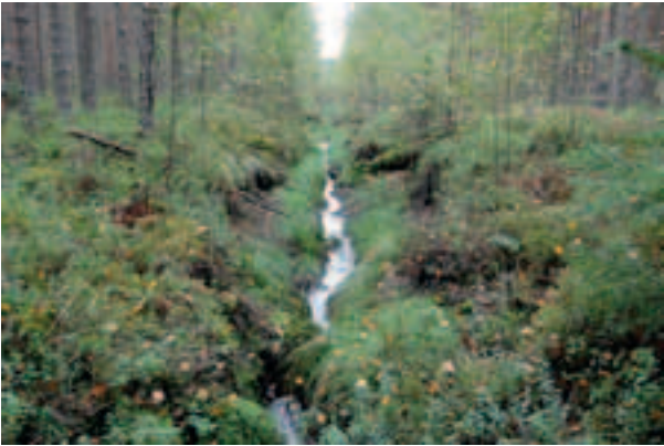
Kuva 30. Kokoojaojassa virtaava vesi on aiheuttanut syväksi kaivetun ojan pohjaan ojaeroosiota. Kuva: Teemu Kiiskinen.
