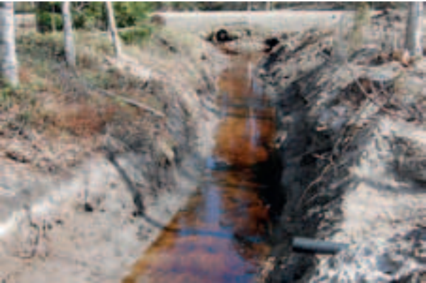
Kuva 17. Ojanpohjassa on havaittavissa ojaeroosion merkkejä loppukeväällä 2012. Kuva: Teemu Kiiskinen.
