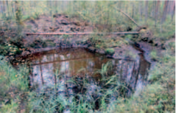
Kuva 28. Laskeutusallas syksyllä 2012. Tulouomassa ojan pohjan korkeusero ympäröivään metsään on noin 1 metri. Kuva: Teemu Kiiskinen.
